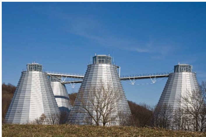
Faultürme für das Klärwerk der Stadtentwässerung München
