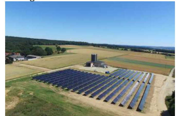
Quelle: Bürgergenossenschaft Mengersberg, Solarthermiefeld
